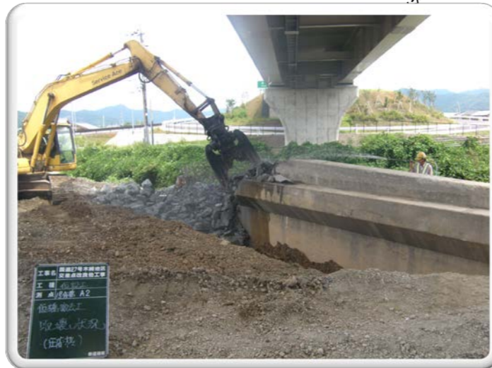
仮橋取壊し状況
