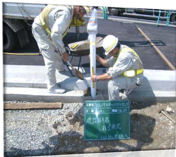
視線誘導標設置
