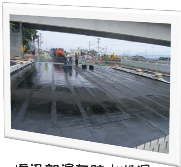
橋梁部塗布防水状況
