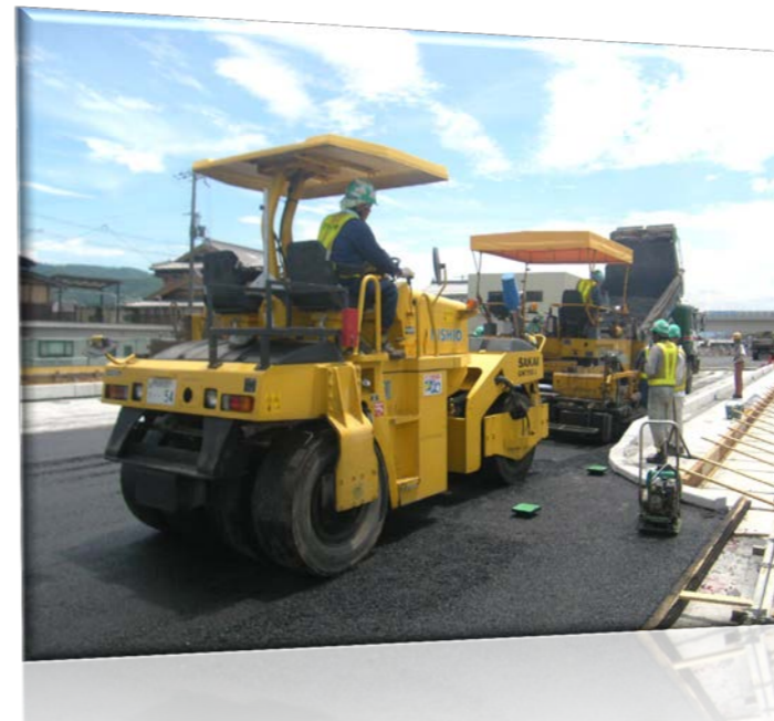
橋梁舗装状況
