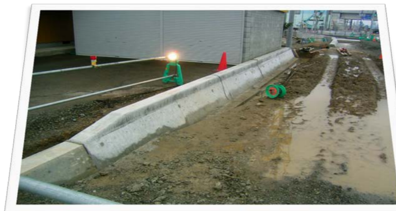
池田宅前コマ止め施工完了
