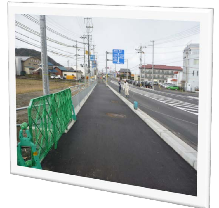
歩道舗装完了
