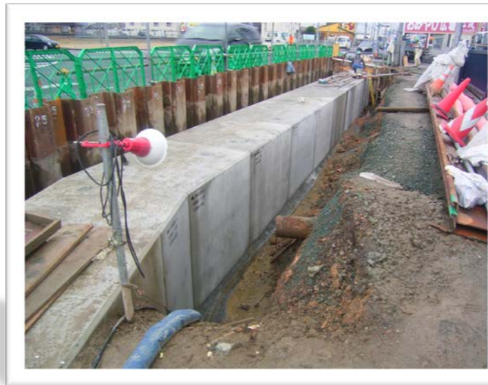
コマツサービスエース前ボックス据付完了
