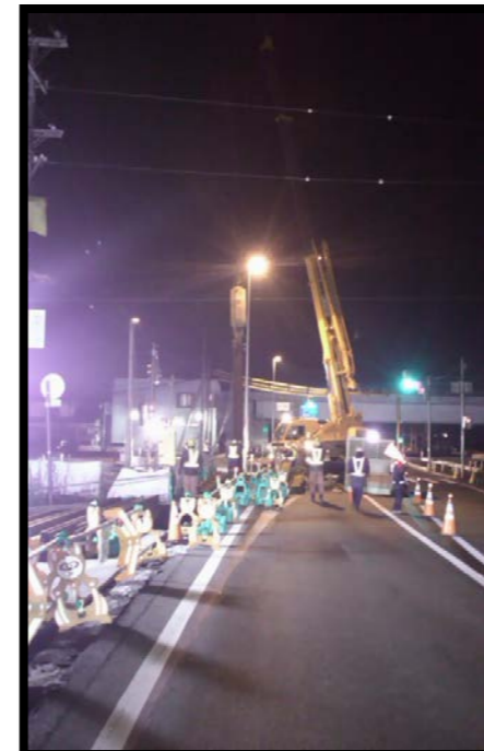
夜間工事 道路にクレーンを据えて矢板を打ちこんでいます
